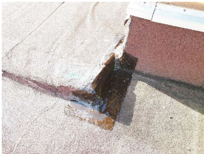
Mise en oeuvre de résine d'étanchéité
