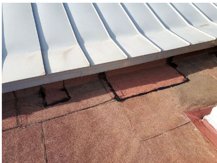
Mise en oeuvre de patch d'étanchéité
