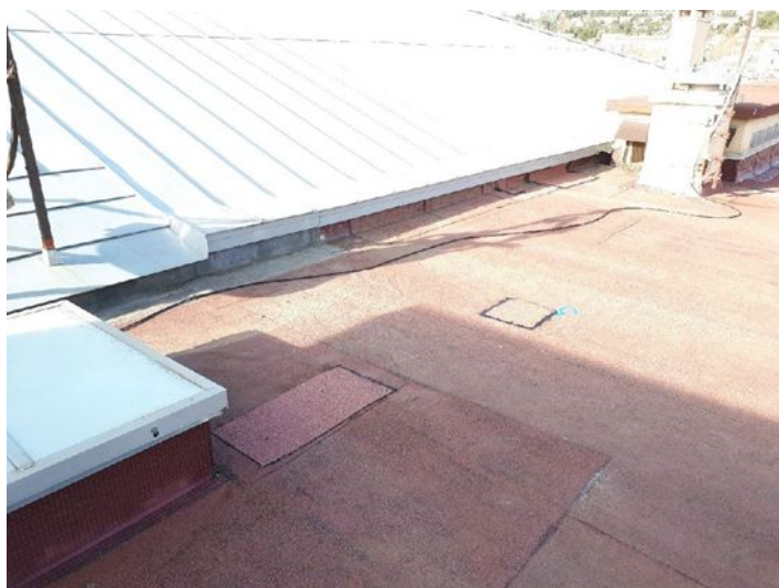
Mise en oeuvre de patch d'étanchéité
