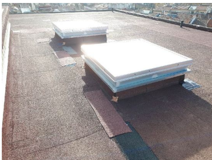
Mise en oeuvre de patch d'étanchéité
