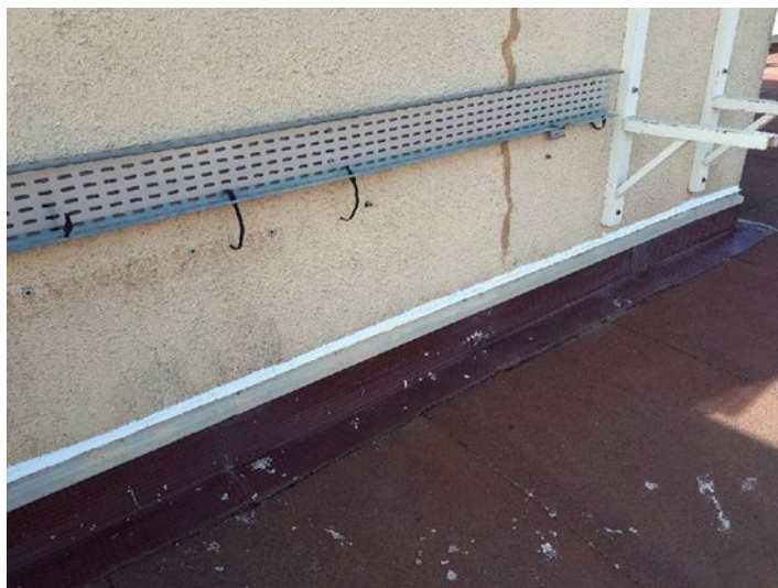
Restauration de joint PU sur bande soline
