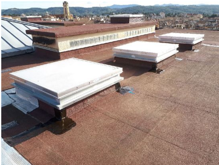
Mise en oeuvre de résine d'étanchéité
