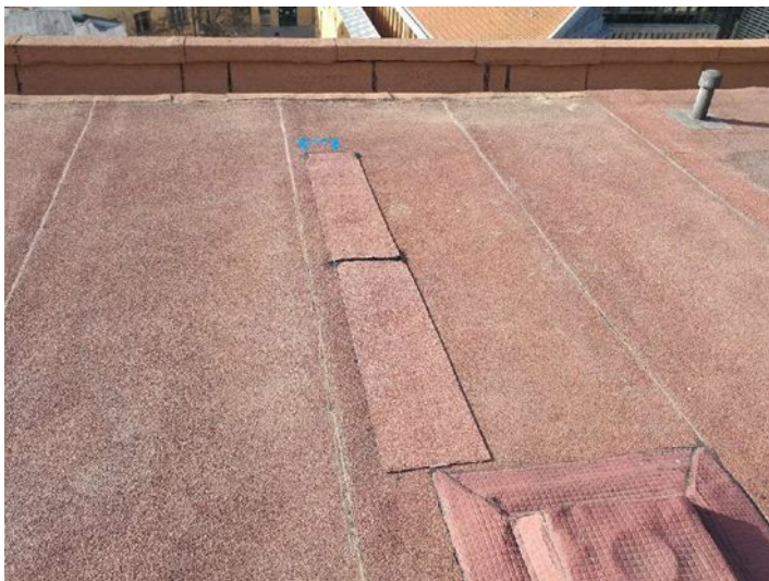
Mise en oeuvre de patch d'étanchéité
