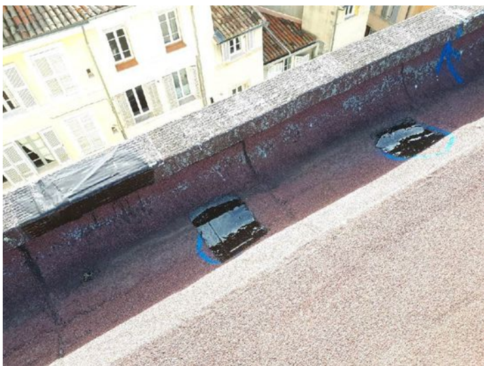
Mise en oeuvre de résine d'étanchéité
