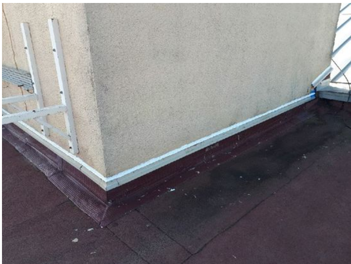
Restauration de joint PU sur bande soline
