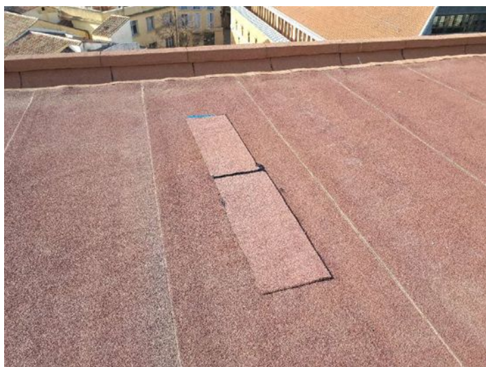
Mise en oeuvre de patch d'étanchéité
